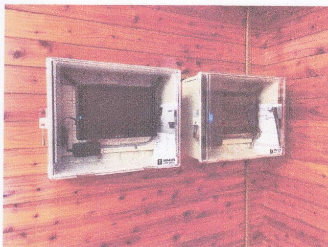
会館2階のモニター設置状況(施工中)
